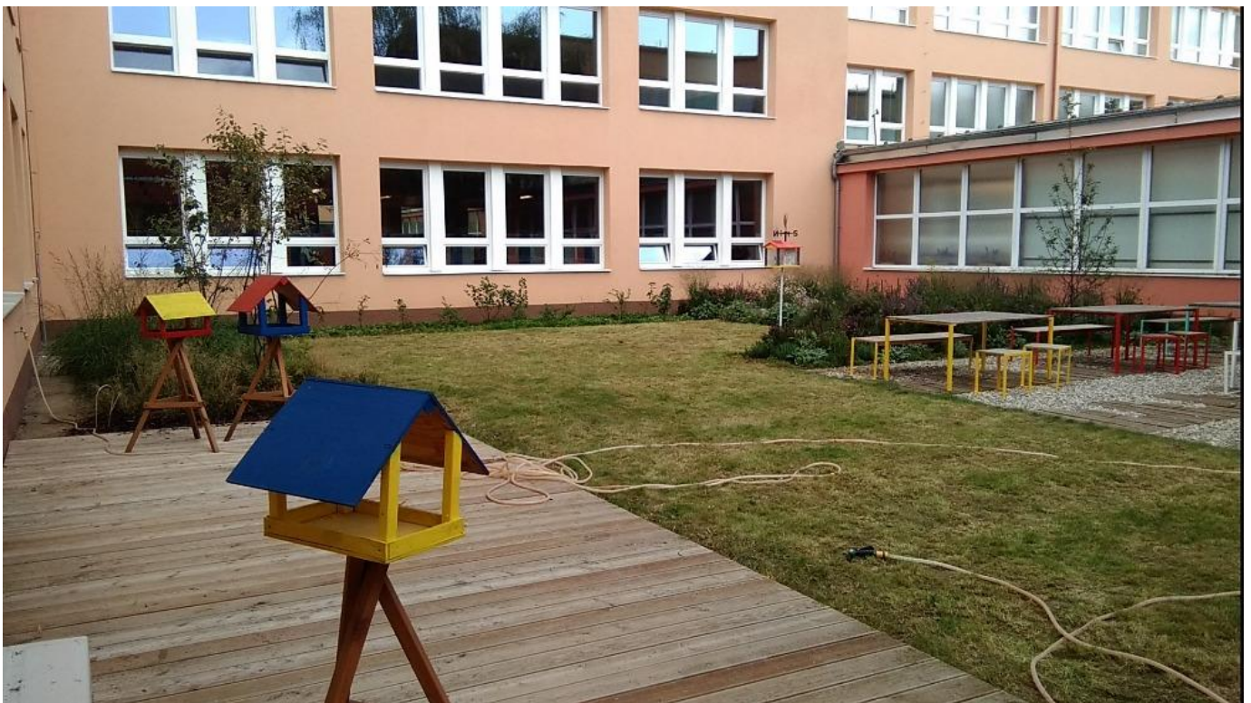
Vnitřní atrium po rekonstrukci – podzim 2019
