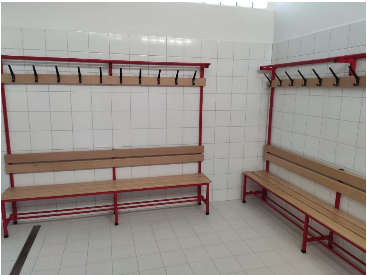
Dívčí šatny – bazén
