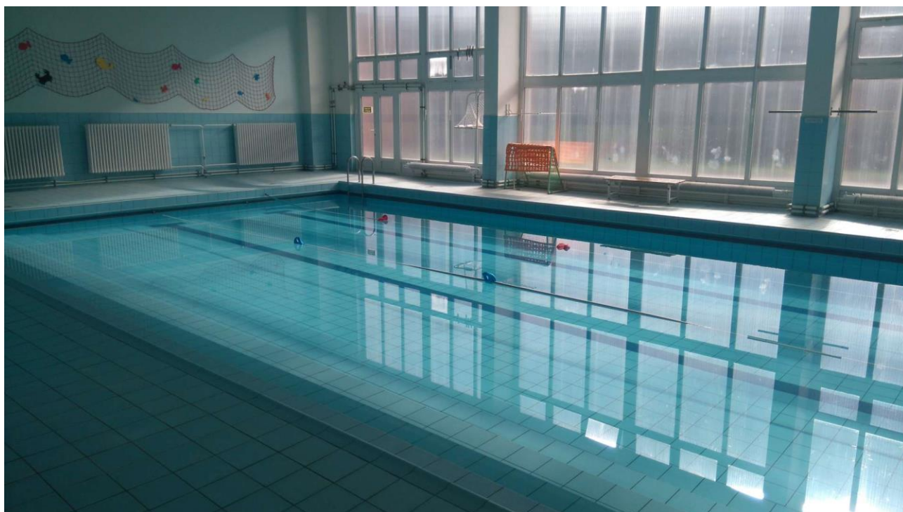
Bazén před celkovou rekonstrukcí
