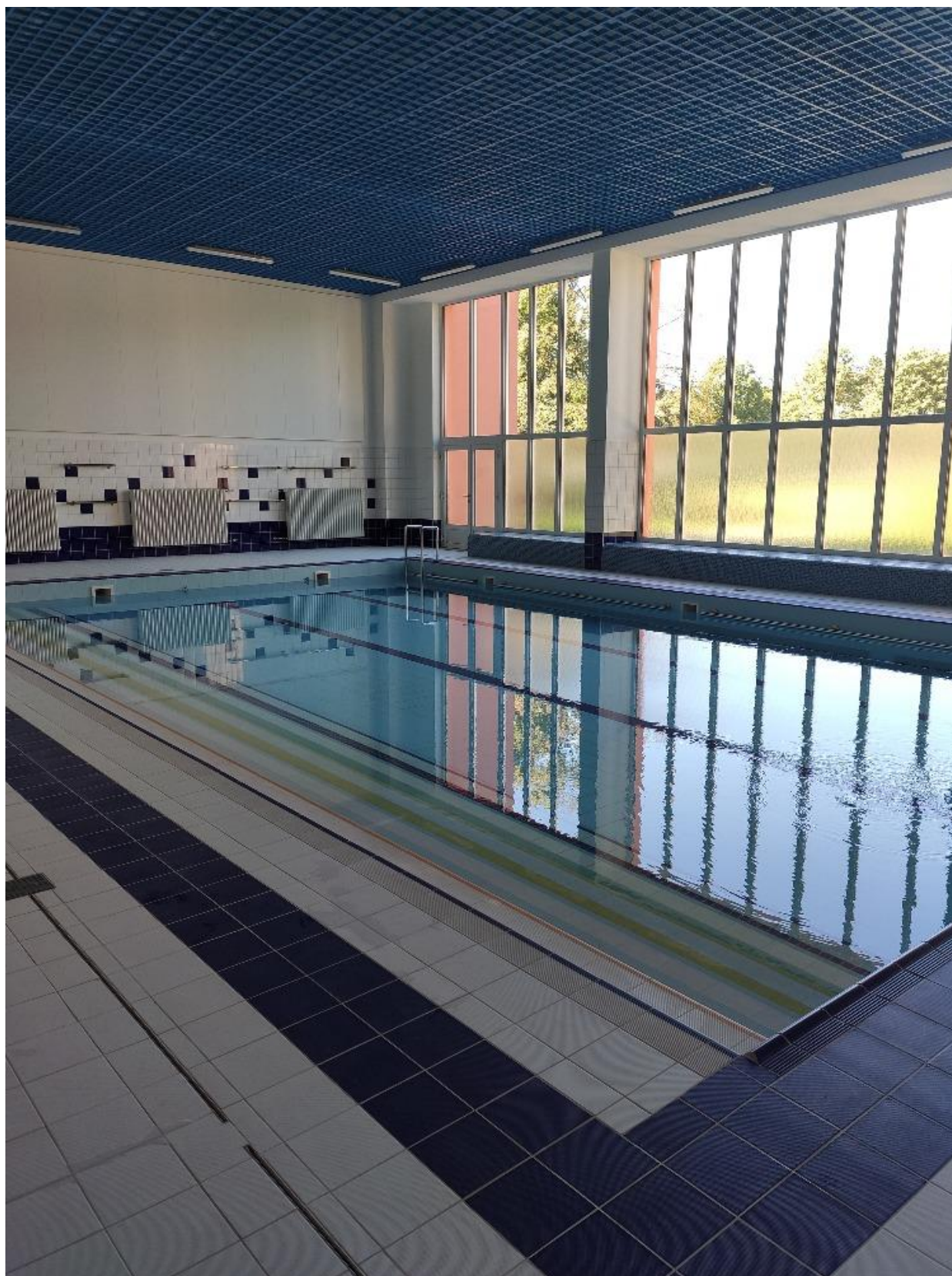
Bazén po celkové rekonstrukci
