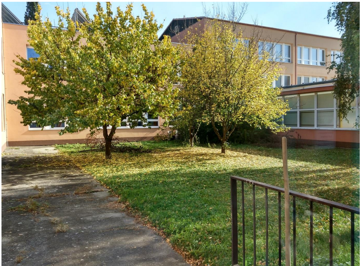
Vnitřní atrium před rekonstrukcí – podzim 2018
