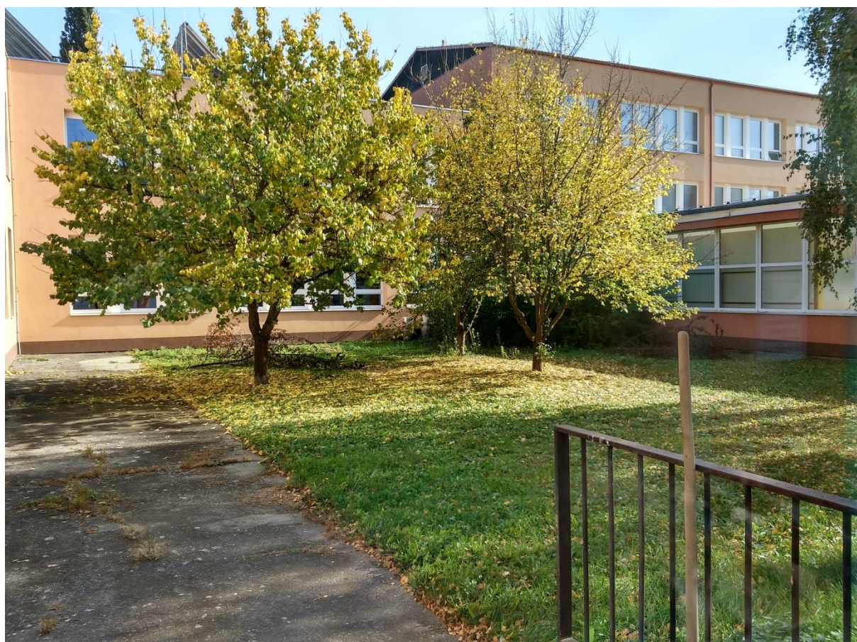
Vnitřní atrium před rekonstrukcí – podzim 2018
