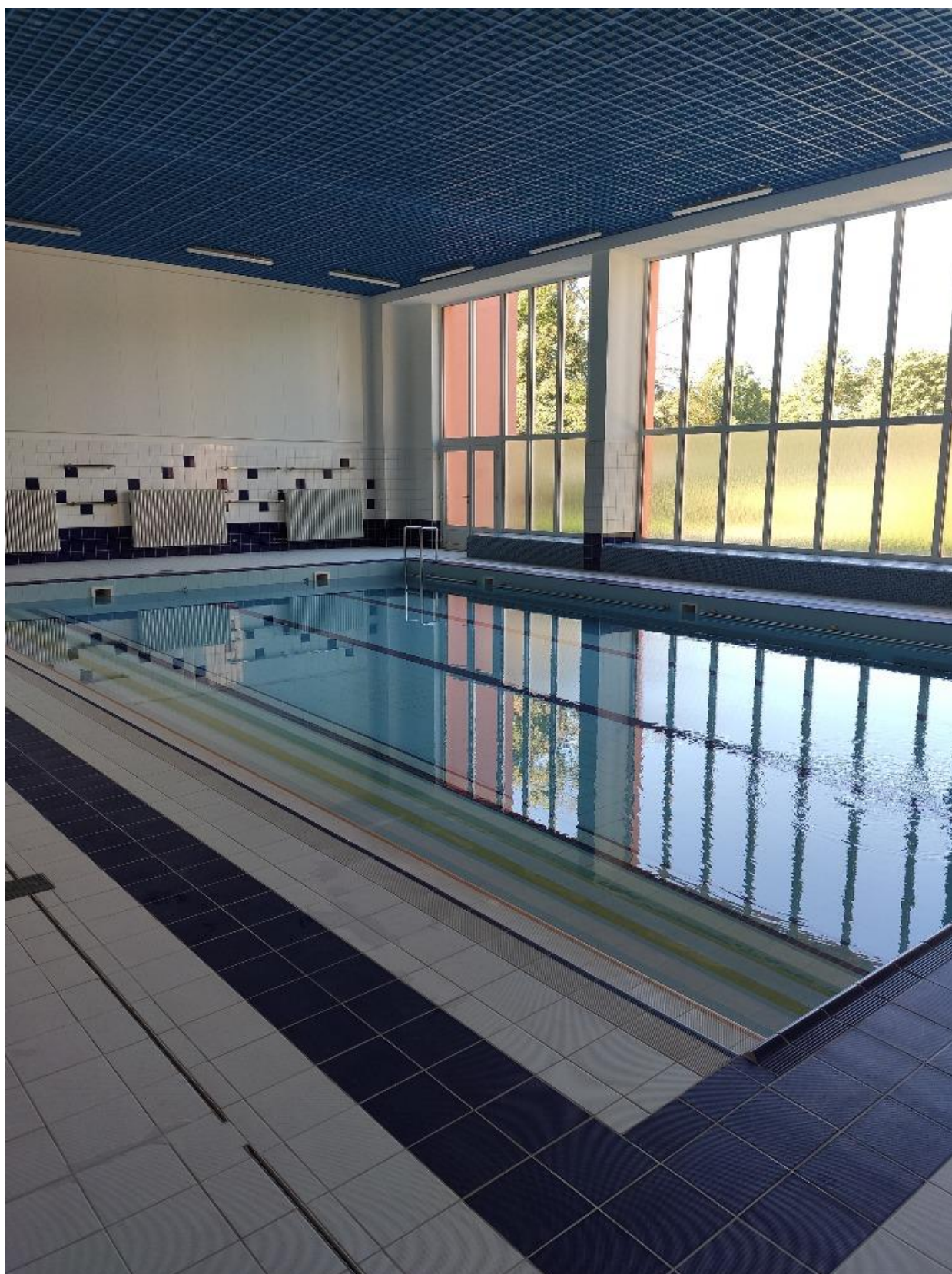
Bazén po celkové rekonstrukci
