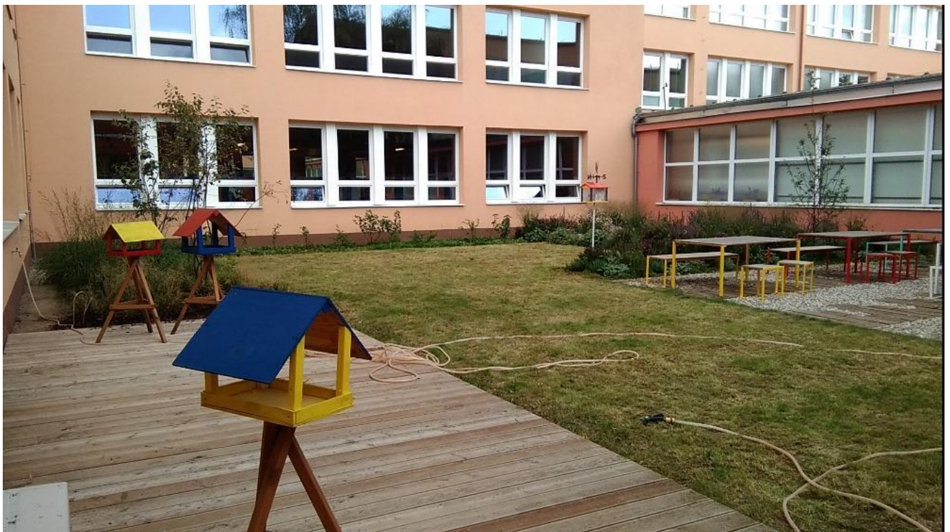
Vnitřní atrium po rekonstrukci – podzim 2019
