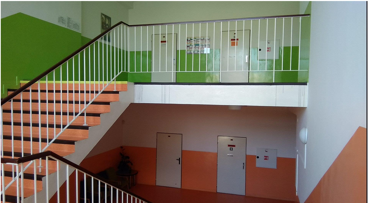
Chodby II. stupně
